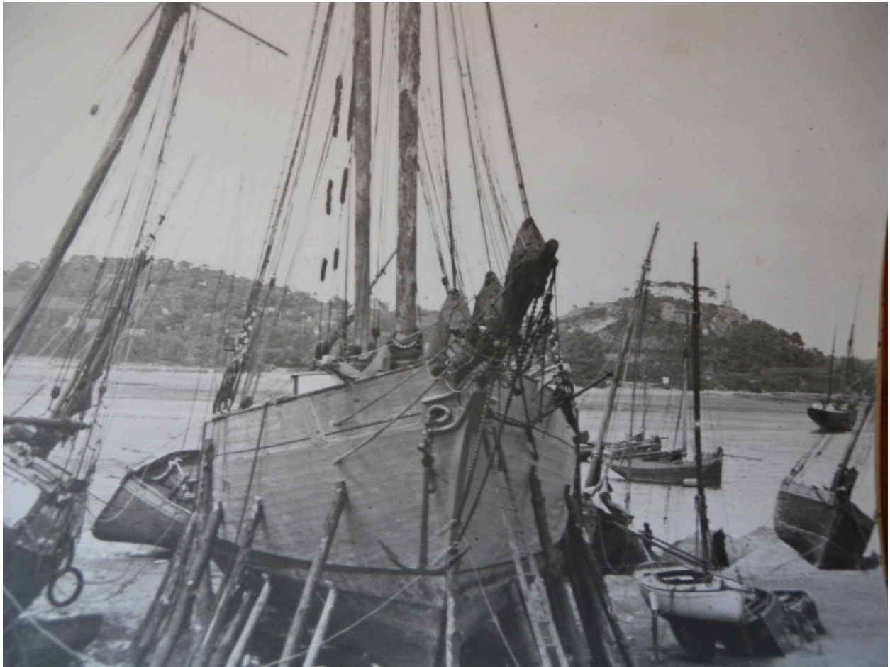
Goélette en chantier dans l'avant-port, devant la cale de Bréhat, 1er quart 20ème siècle (collection particulière)
