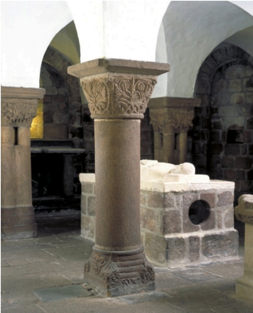
Crypte, travée nord, pilier central
