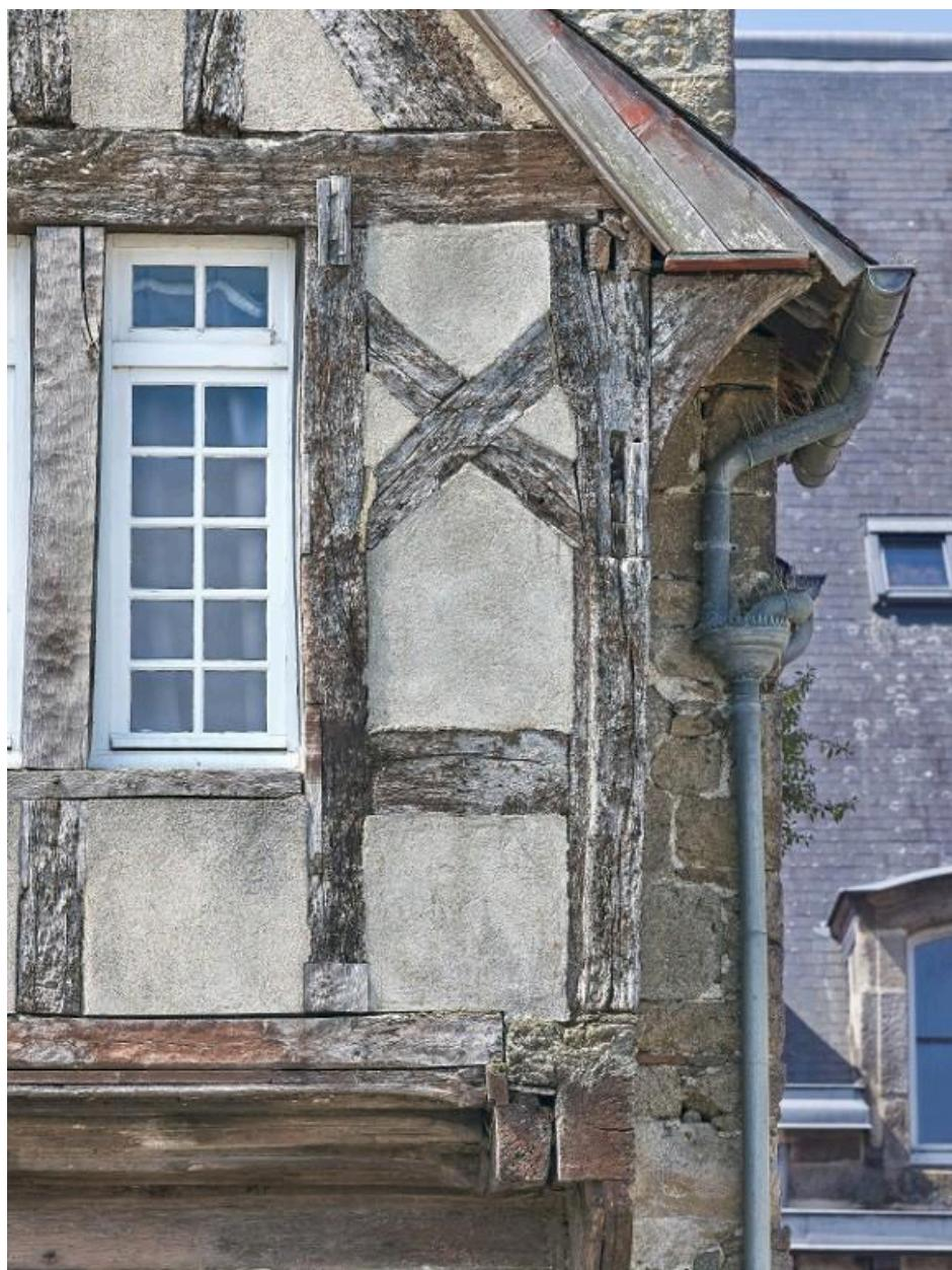
L'assemblage à tenon et mortaise en partie haute du poteau cornier est visible, de même que la mortaise orpheline qui recevait probablement un aisselier.
