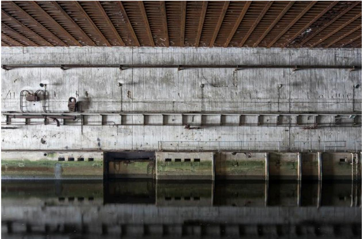
Vue du quai nord de l'alvéole nord : au niveau de l'eau, emplacement de l'un des postes d'amarrage flottant. Sur le mur, boîtier de connexion électrique avec voltmètre, système de chauffage et de ventilation, lampes murales et chemin de câble. En haut, chemin de roulement du pont
