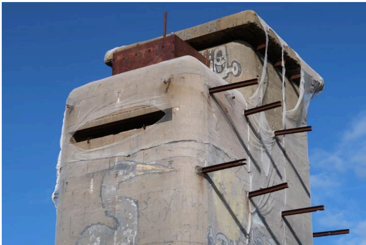
Vue de détail du bunker - poste de direction de tir depuis le sud : partie sommitale
