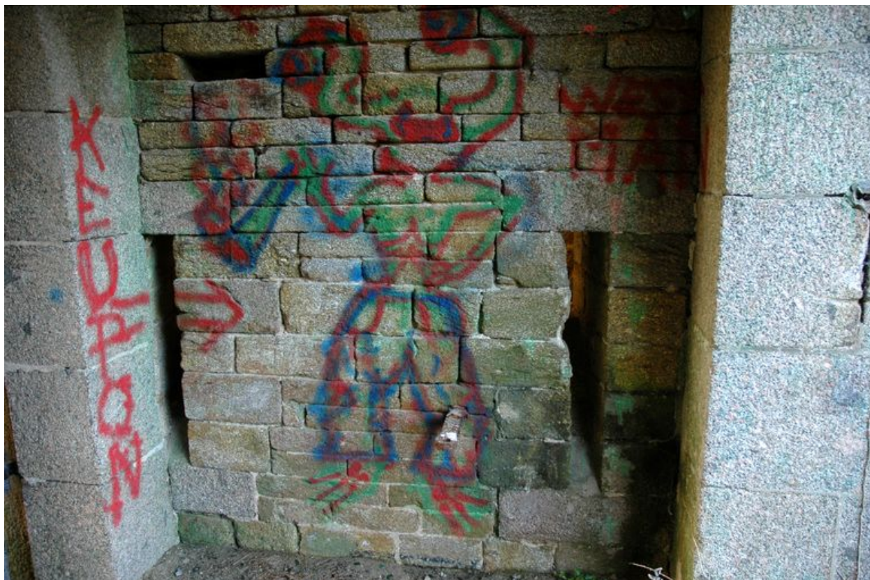
Vue du sas d'entrée : créneaux de fusillade (état en 2006)
