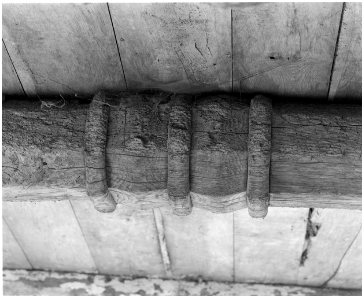
Sacristie : partie centrale de la poutre sud
