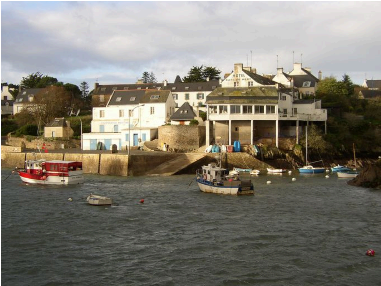
Vue générale de la zone d'activité portuaire artisanale du quai Peyron
