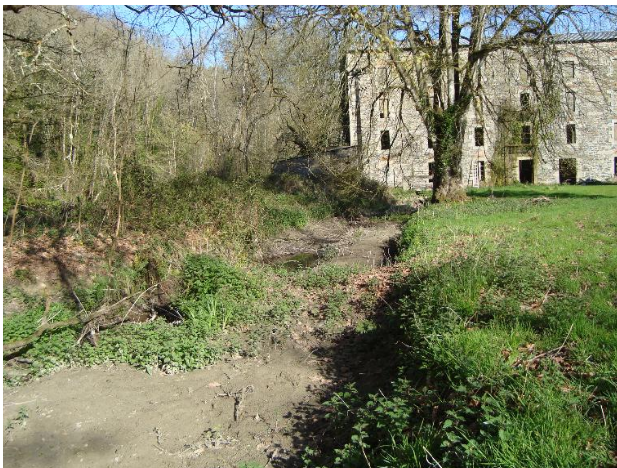
Bief de la cartonnerie, bâtiment 1 abritant la turbine
