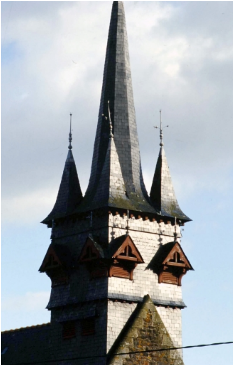
Partie haute du clocher, vue générale.
