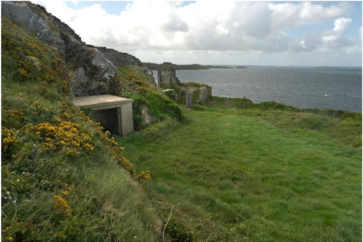
Vue du terre-plein de la batterie basse depuis le nord (état en 2009). A gauche, l'abri de jour du poste photo-électrique (projecteur de 90 cm de diamètre)
