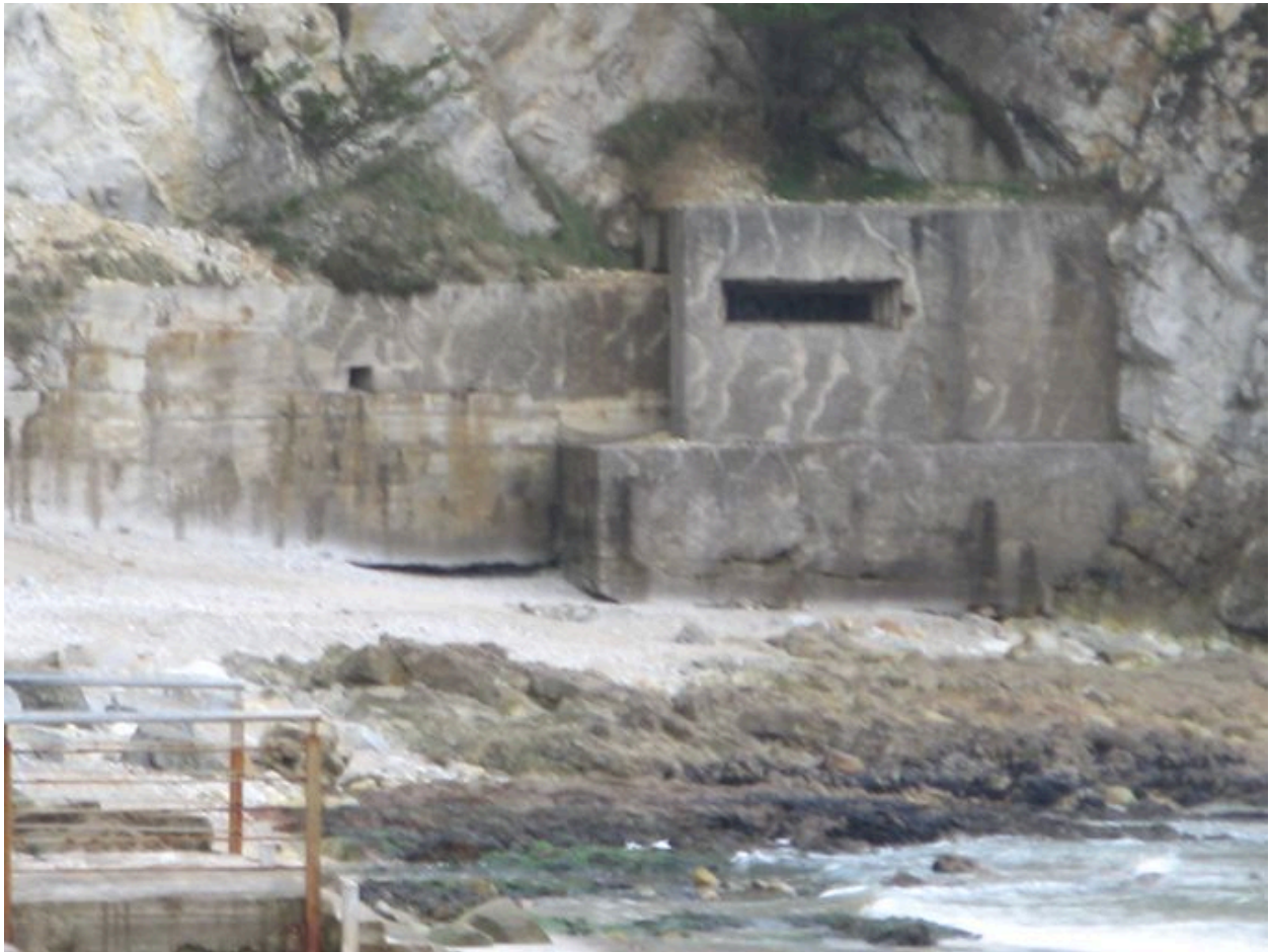
Vue générale de la casemate de Rulianec
