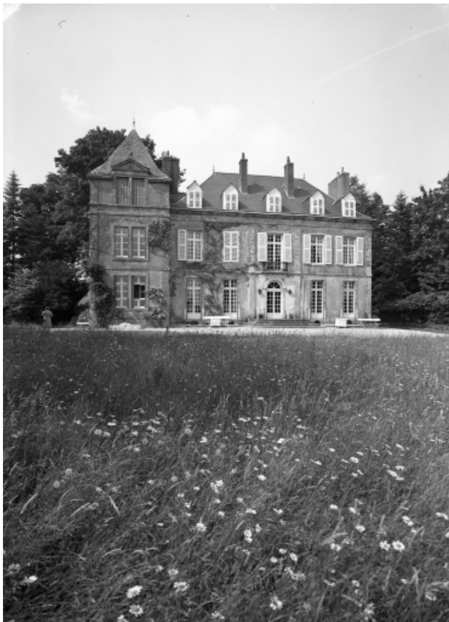
Vue générale de la façade sud
