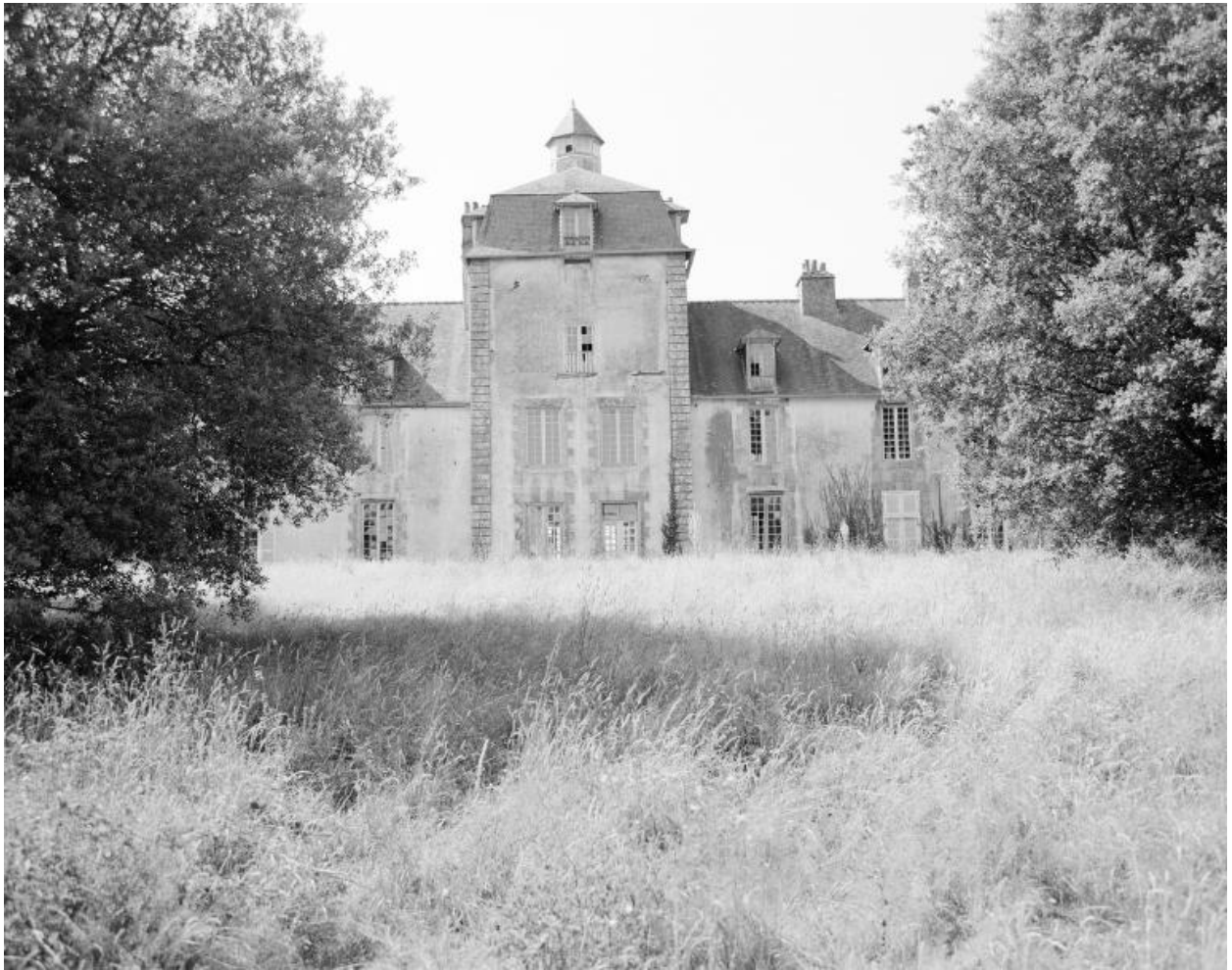
Elévation sud, partie centrale, vue prise de l'ouest.
