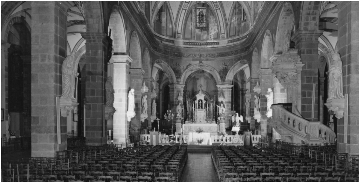
Vue générale vers le choeur.
