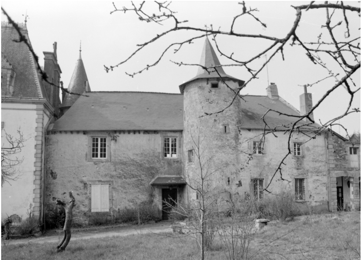
Logis du 17e siècle : vue générale depuis l'est (état en 1988)
