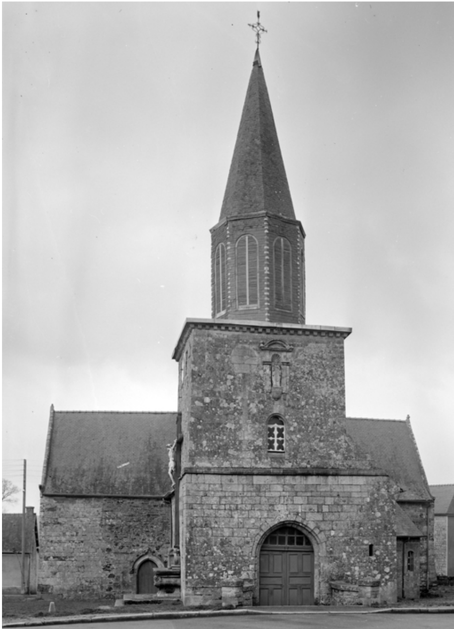
Vue d'ensemble de la façade ouest
