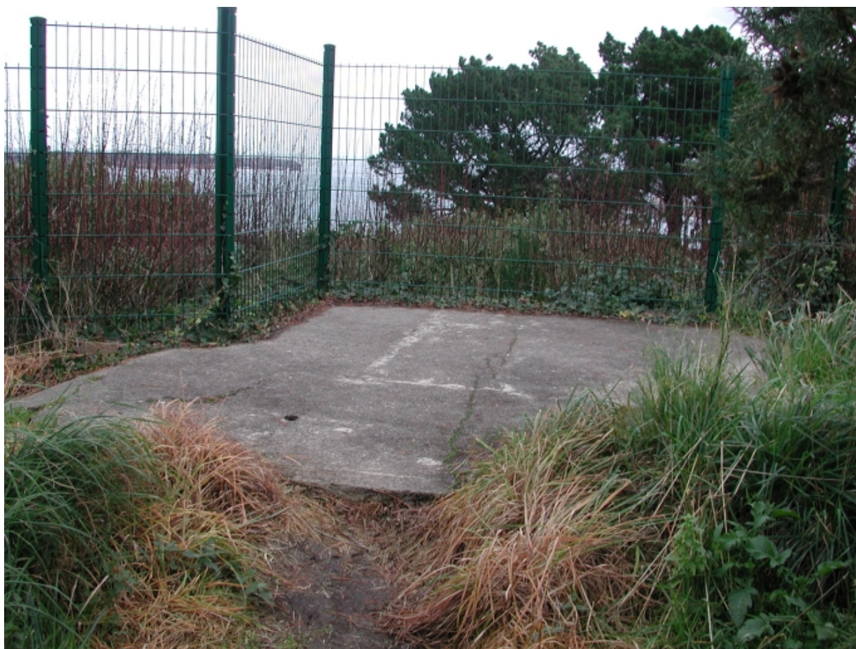
Vue d'un blockhaus sur le plateau de l'Arcouest, dominant le front de mer
