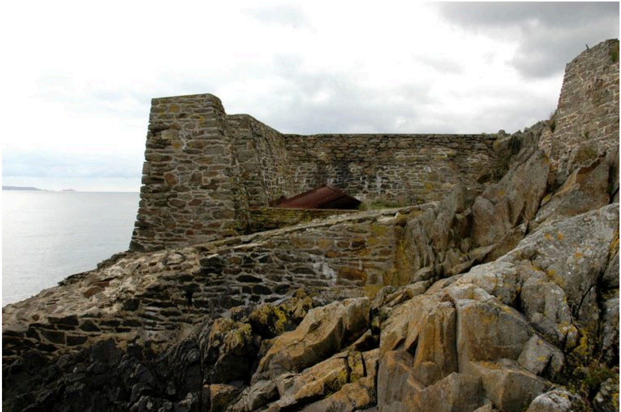
Vue du tube de lancement (état en 2006)
