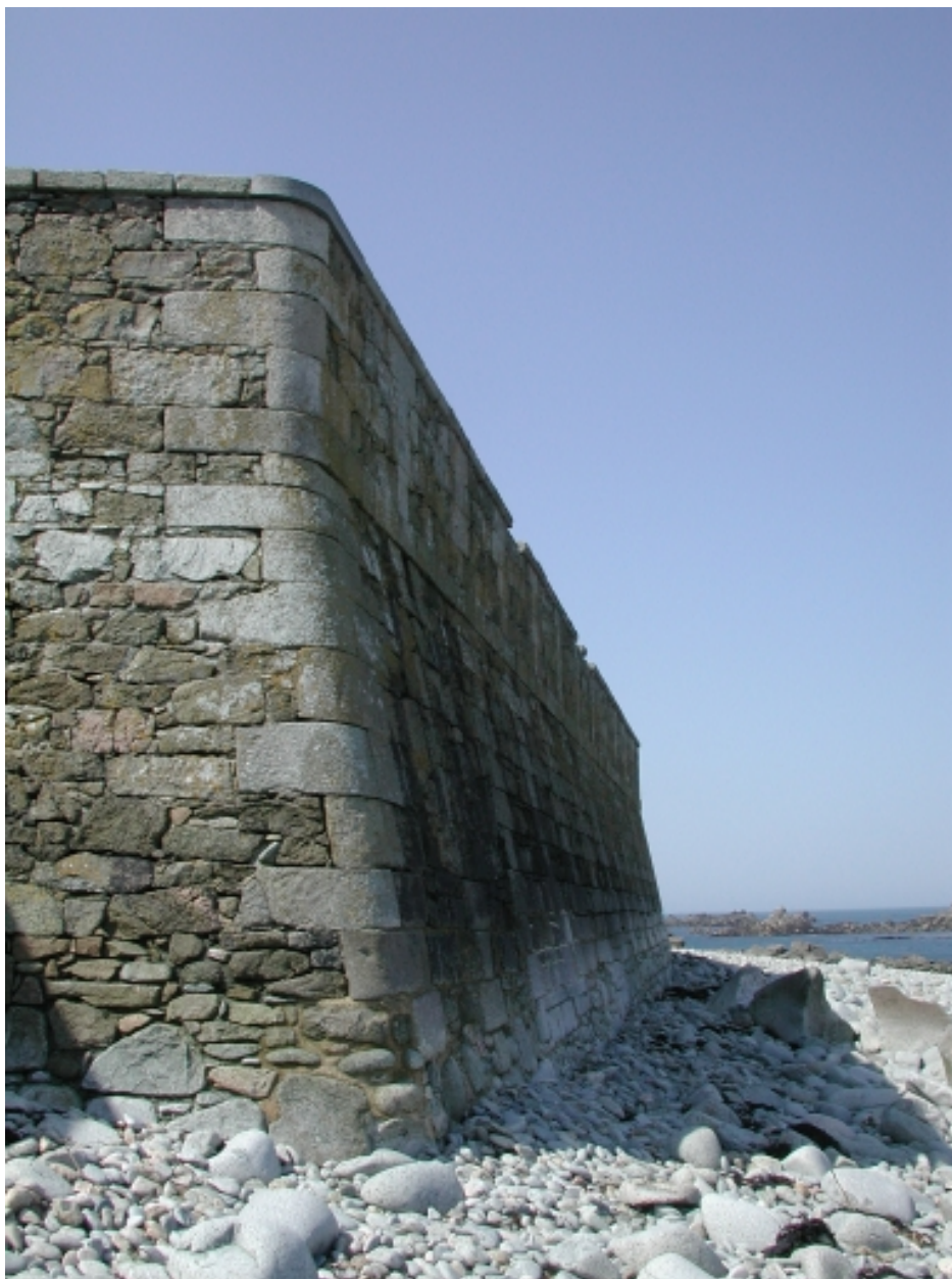
Vue du mur de retour du mur d'enceinte côté est
