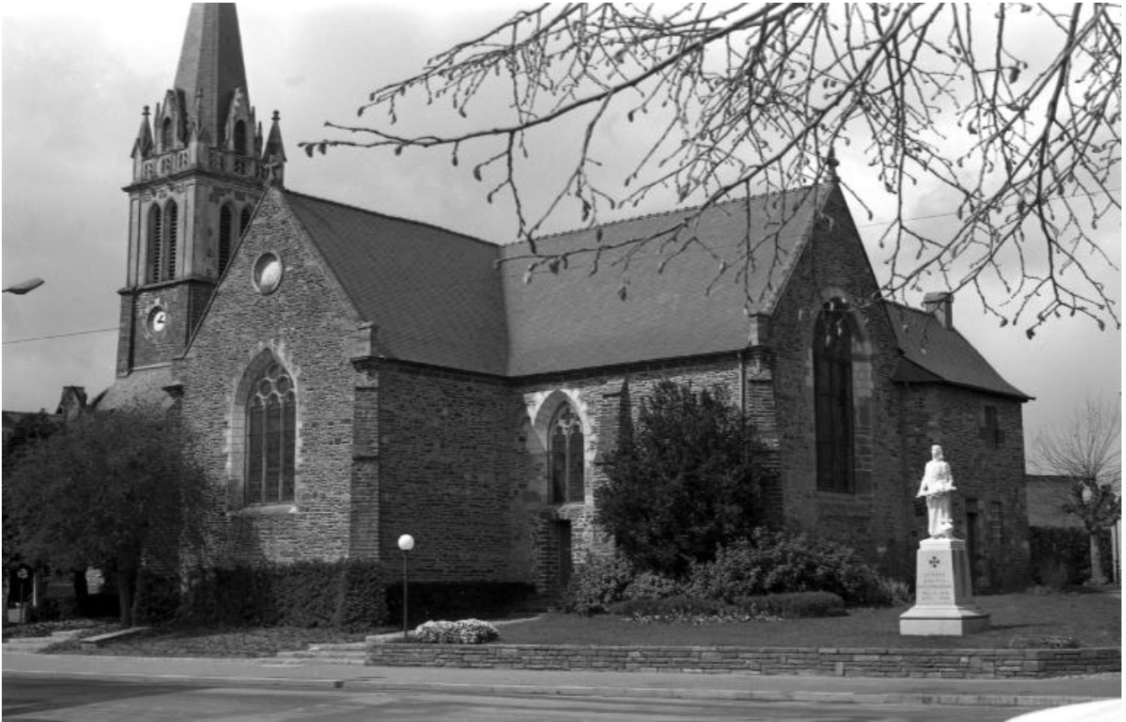
Eglise paroissiale - Vue générale sud est
