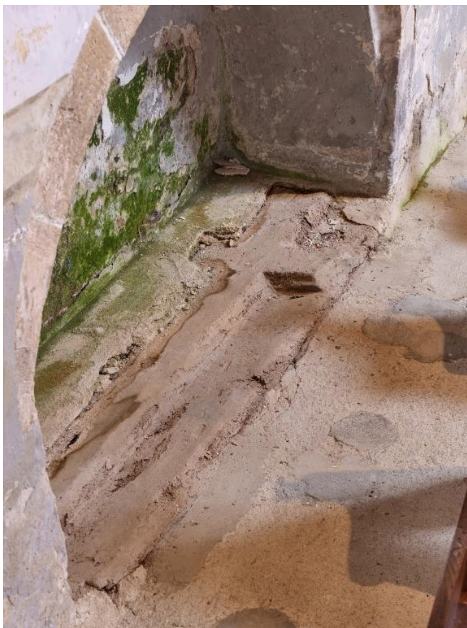
Enfeu, mur sud de la nef
