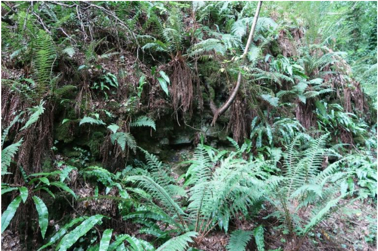
Vue des vestiges : mur en pierre maçonnée
