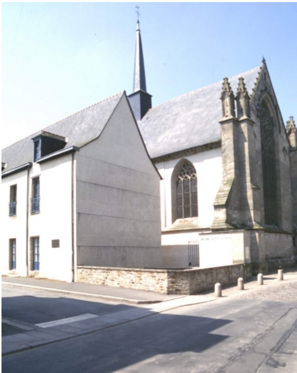
Pignons sud est : vue générale.
