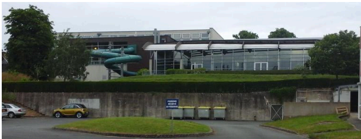
Extension de la piscine, façade sud
