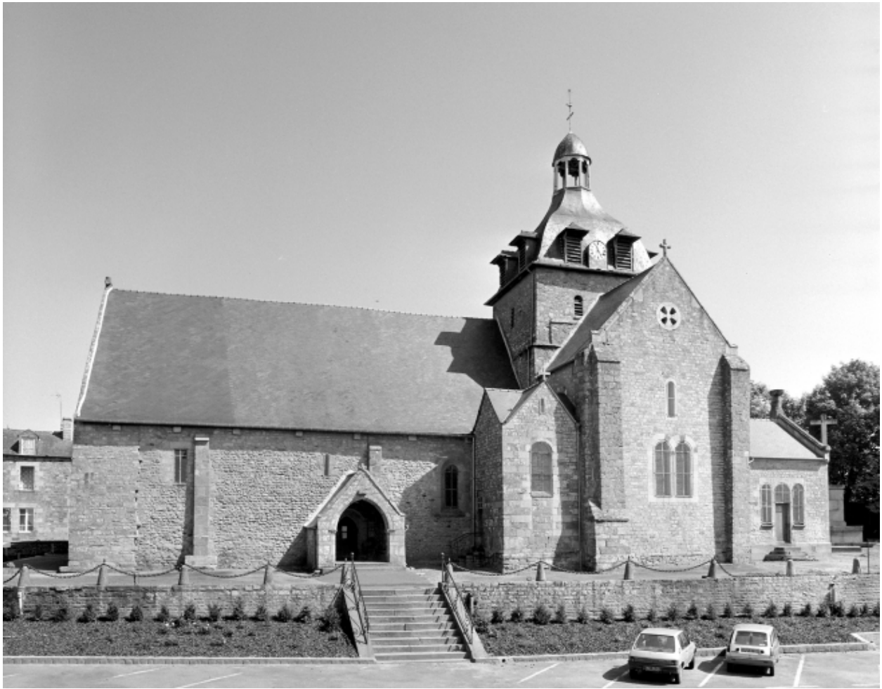
Elévation sud : vue générale
