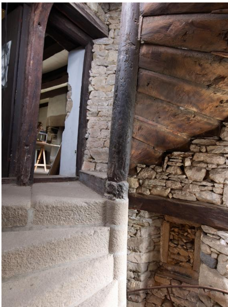
Tour d'escalier. Vue intérieure. Transition entre la partie en pierre et la partie en bois de la vis
