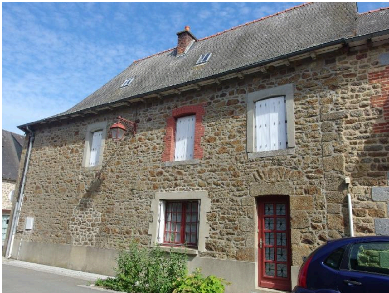
Vue de la façade sud
