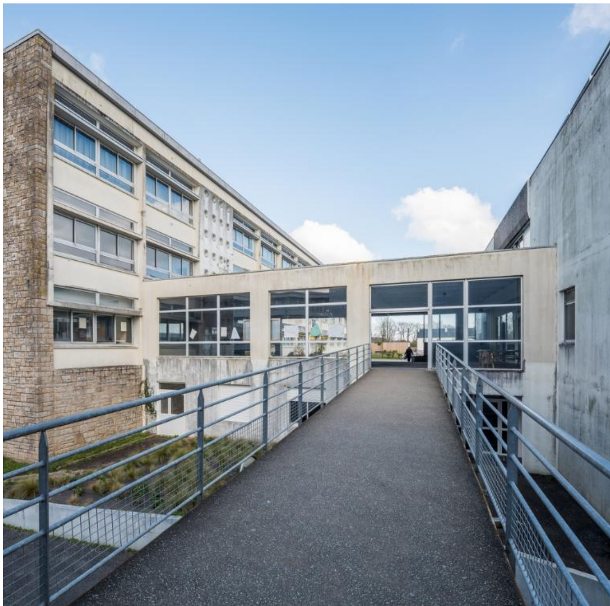
Passerelle entre les trois externats.
