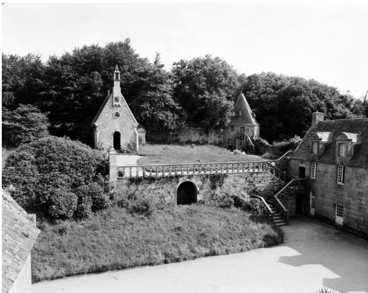
Galerie, chapelle et ancienne maison du chapelain, vue générale nord
