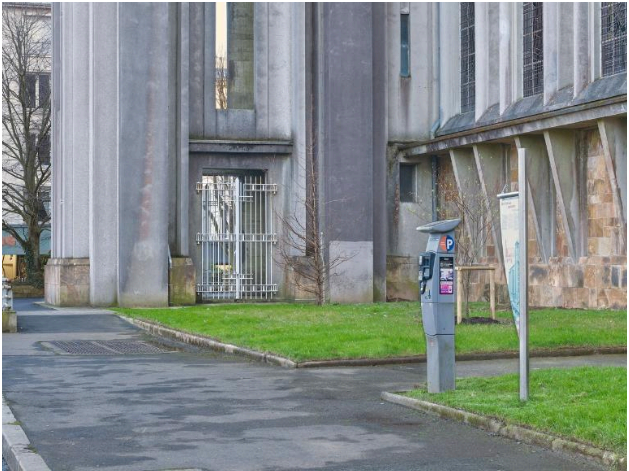
Eglise Saint-Louis, mur ouest
