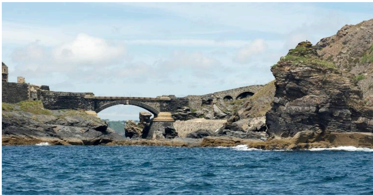
Roscanvel : vue de l'ensemble fortifié de l'îlot des Capucins depuis la mer, face sud, le pont
