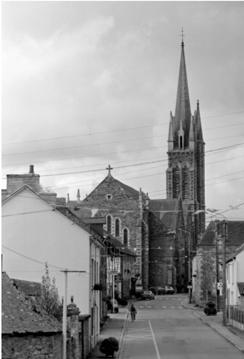
Elévation Nord-Est : vue générale
