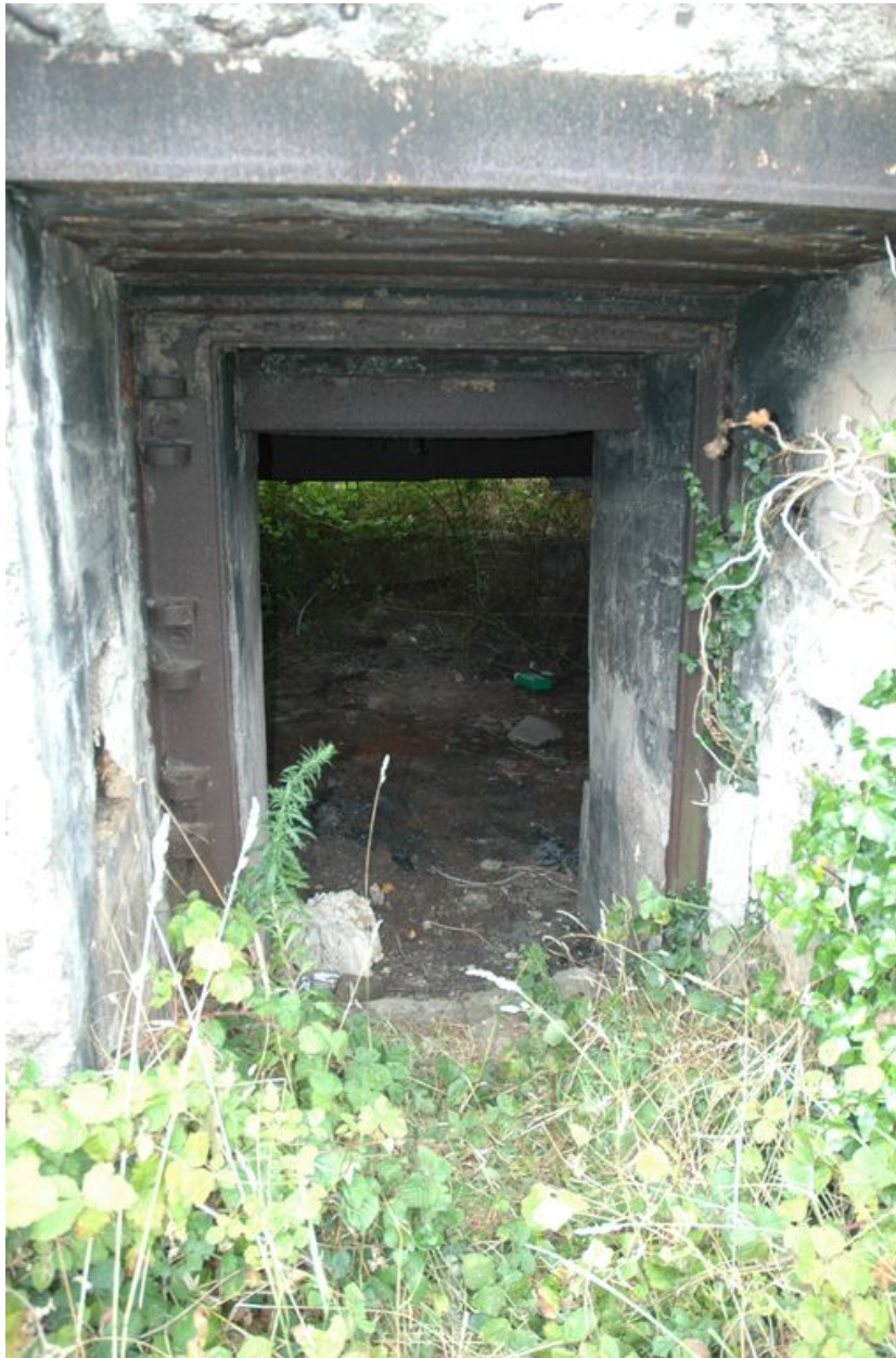
Vue de l'un des quatre bunkers-casemates de type 671 : entrée orientée vers le sud (état en 2008). Le couloir dessert la chambre de combat
