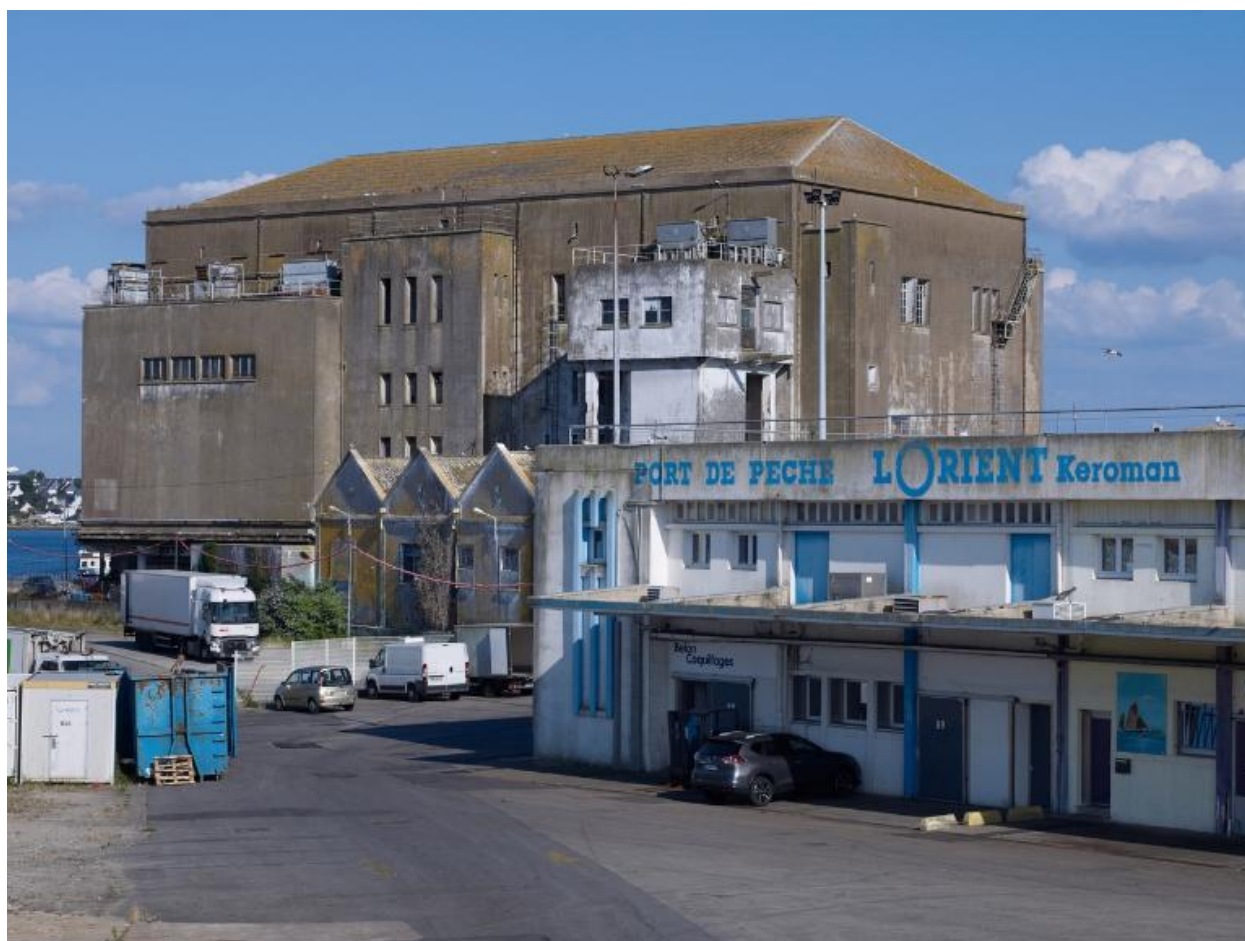
Frigorifique de Keroman, vue générale
