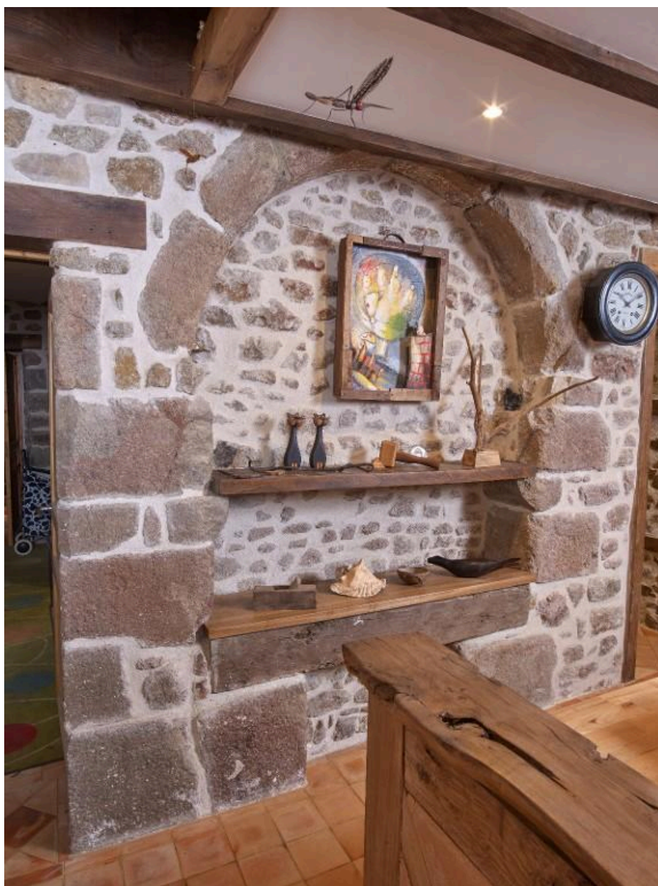
Salle est. Mur de refend. Vaisselier mural avec l'emplacement du lave-mains dans la partie inférieure
