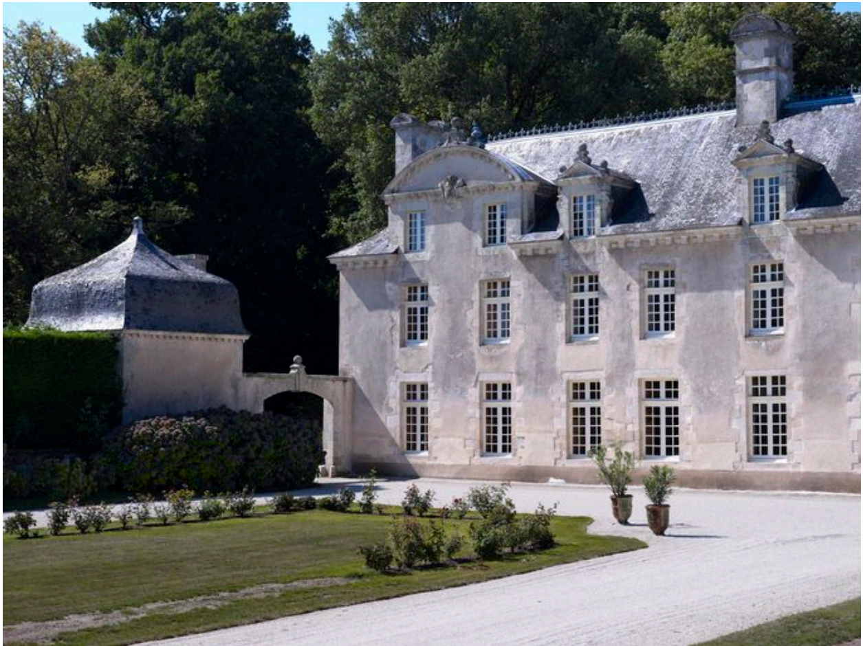
Château, corps de logis : élévation est, la partie sud (état en 2010)
