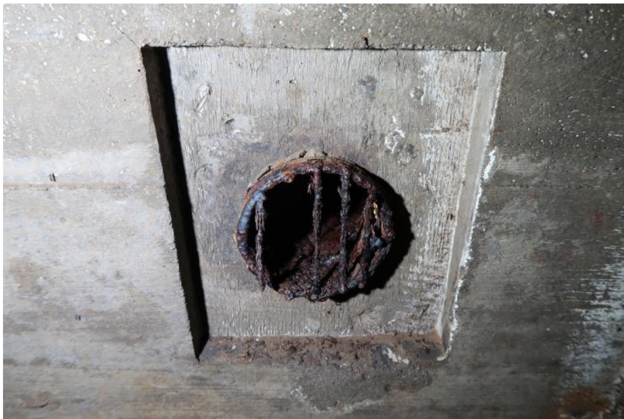
Vue de l'entrée sud : tuyau doté d'une grille
