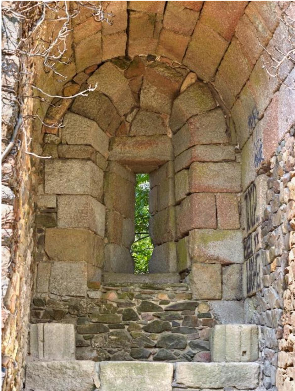
Vue du rez-de-chaussée surélevé : casemate/meurtrière percée d'une arbalétrière-canonnière (fente pour le tir à l'arbalète ou à l'arc et orifice rond pour le tir avec des pièces d'artillerie). Sa maçonnerie a été remaniée en partie basse
