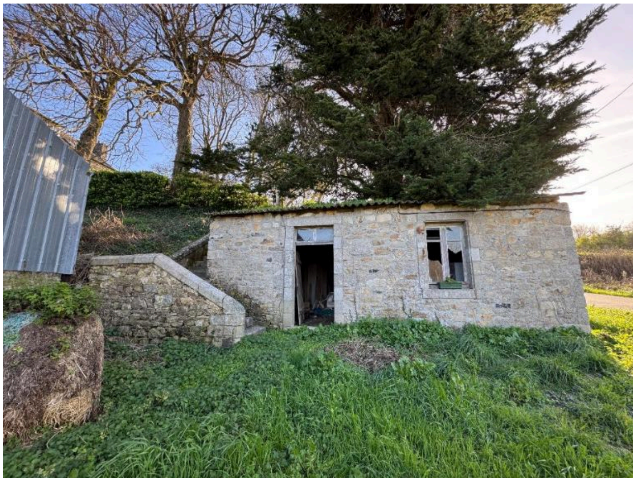
Petite dépendance et départ d'escalier menant à la maison patronale. Vue nord
