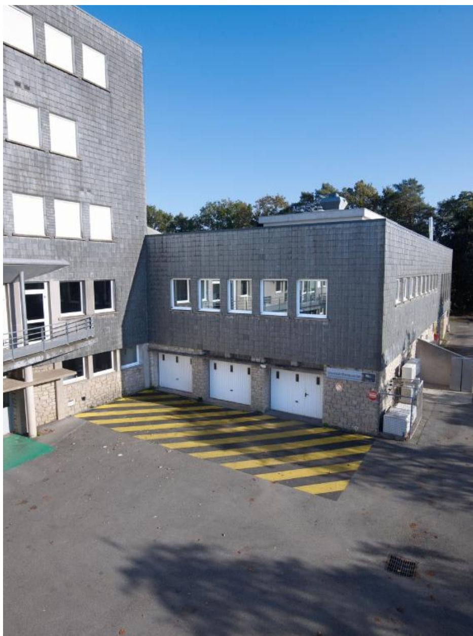
Bâtiment A, internat-restauration, détail de la façade sud-ouest (Yves Guillou architecte, 1965).
