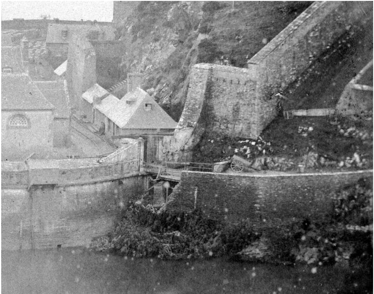
Vue du fort du Mengant en 1877 : détail de l'entrée du fort, pont-levis
