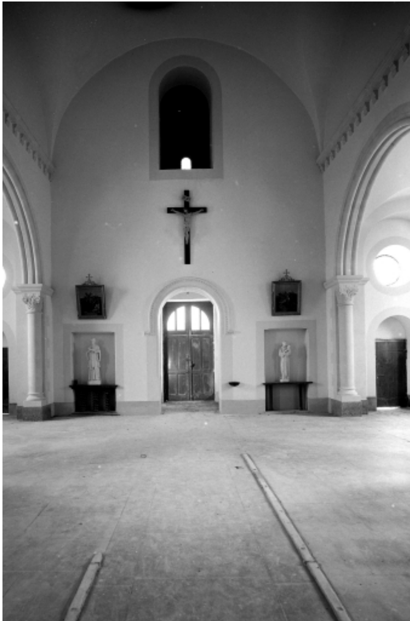
Intérieur, nef, mur ouest : vue générale.
