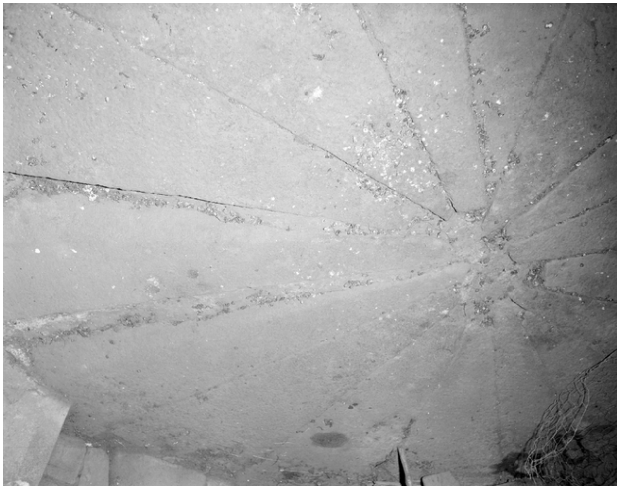
Sol du comble
