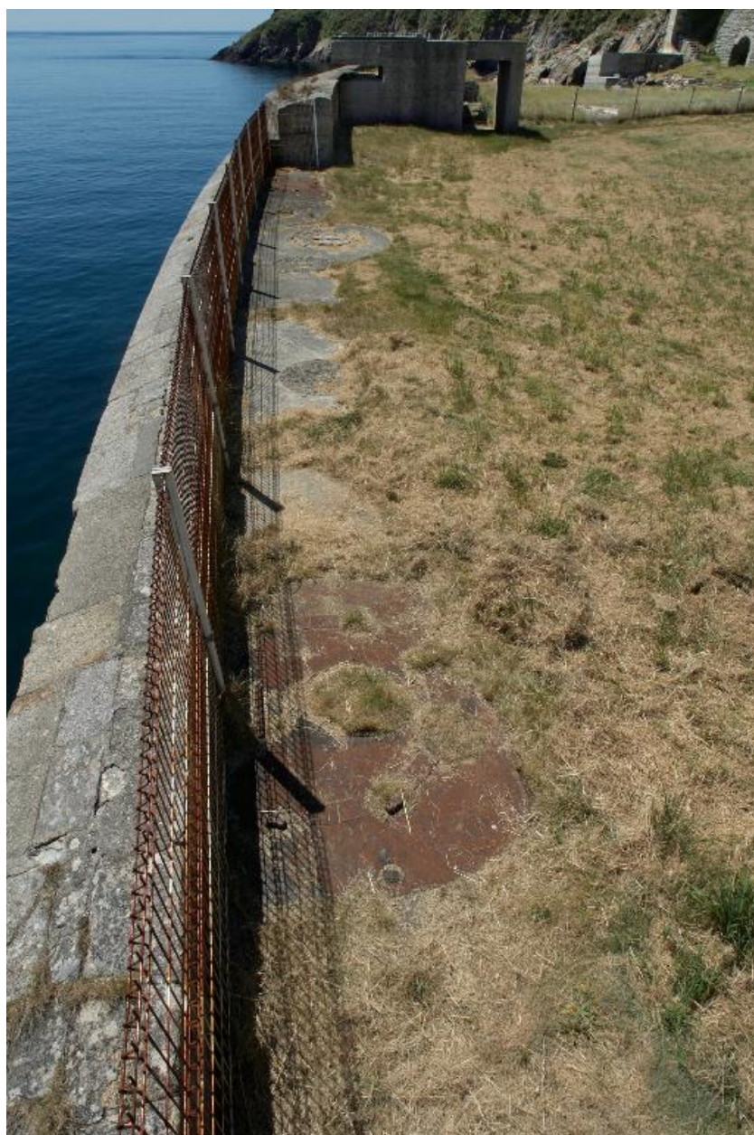
Plouzané : vue du fort du Mengant, détail de la batterie basse, sous-sellette d'affût pour canon de 47 mm à tir rapide
