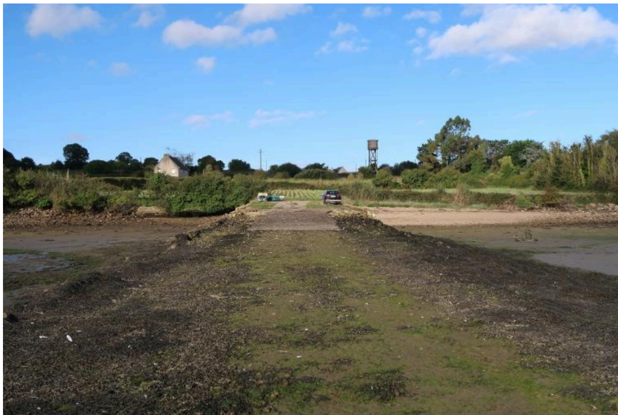
Vue générale du slipway depuis son extrémité orientale. Le réservoir d'eau douce surplombe le site
