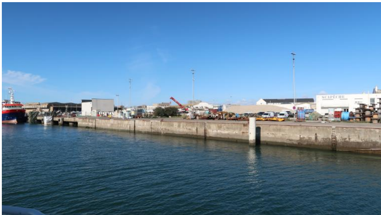
Quai sur pieux métalliques (1975)
