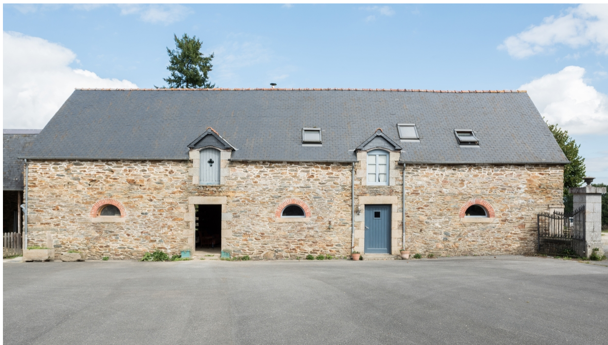
Etable, élévation sud-ouest, vue générale
