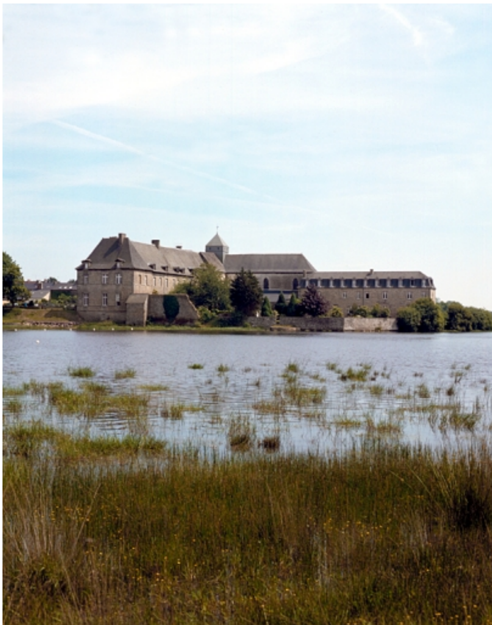
Vue partielle nord-ouest
