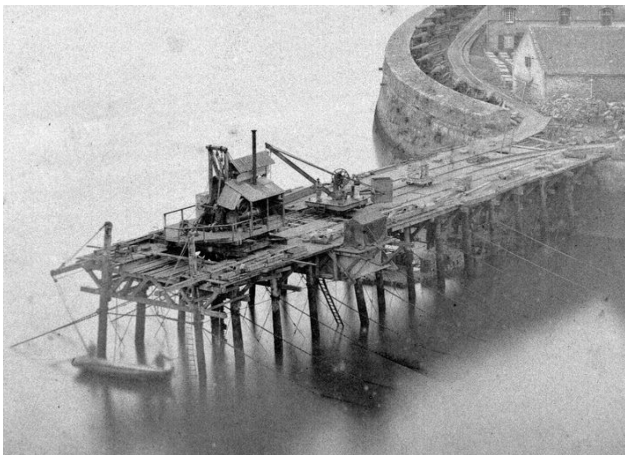
Vue du fort du Mengant en 1877 : détail du chantier de construction du môle d'accostage
